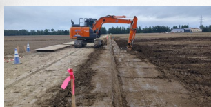
Costruzione di strade
