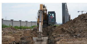
Costruzione di fondazioni
